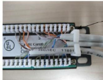
Isolieren Sie etwa 30 mm des Kabelmantels ab und teilen Sie das Kabel in vier Paare.
